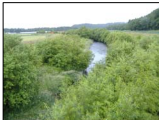
工事完了後の10年程度経過した河川状況
