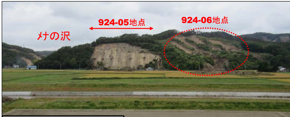
図18 幌内北西のメナの沢口東側の崩壊・地すべり(図19対応)
