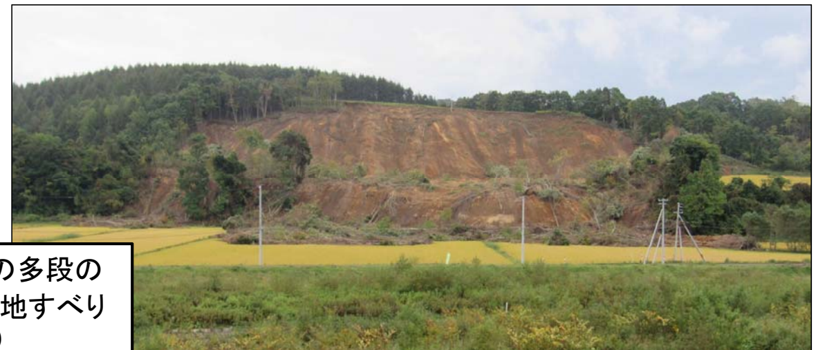
図16 盛り土のある台地際での崩壊(1023-06地点)
