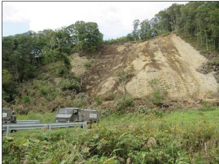
図14 平滑型斜面での小規模崩壊(桜丘; 913-02地点). 左半部は新第三系岩が崩落.
